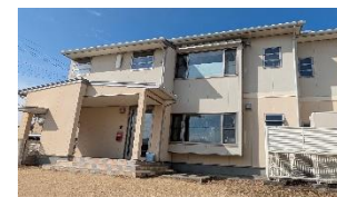
いぶきホーム
